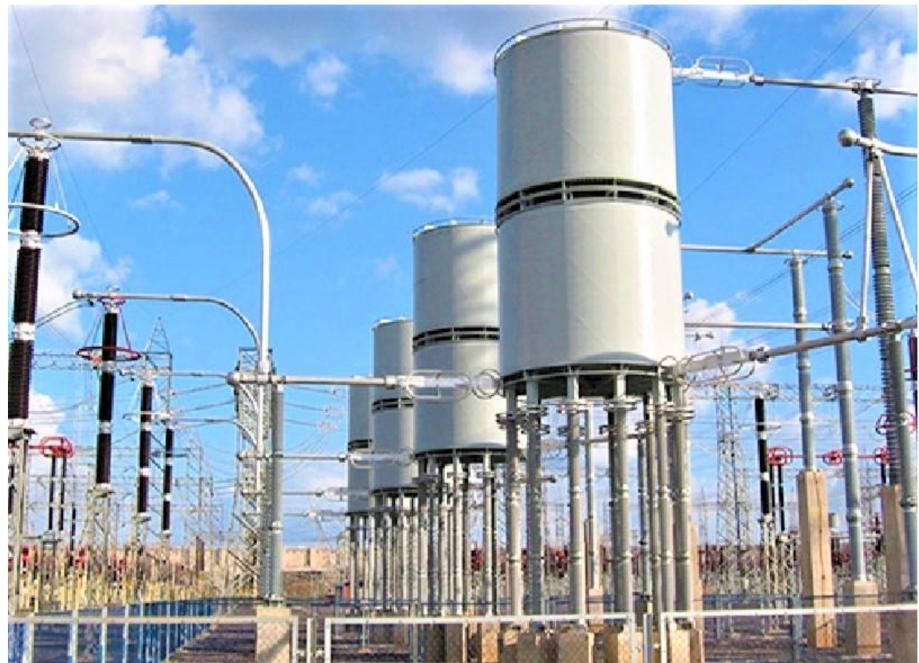
**4. Reactor de alisamiento:** Un reactor de alisamiento se conecta en serie con la línea de alta tensión de corriente continua (CC) como parte de la estación del convertidor o interconexión están integradas entre las diferentes redes de transmisión. Reduce la corriente armónica, limita la corriente de entrada durante las condiciones de falla, limita la magnitud del incremento de la corriente de fase CC y mejora la estabilidad dinámica del sistema de potencia.
