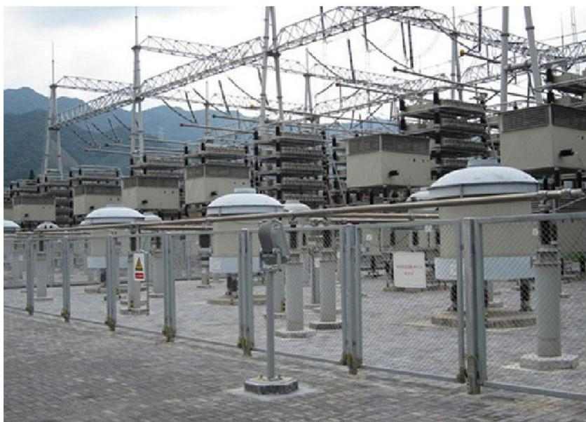
**6. Reactor de amortiguación:** Un reactor de amortiguación está conectado en serie con uno o más bancos de capacitores. Está diseñado para limitar la corriente de entrada de conmutación del condensador y también para soportar la corriente nominal y la corriente de falla en caso de cortocircuito.
