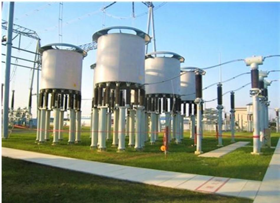
**2. Reactor controlado por tiristores:** Un reactor controlado por tiristores [TCR] es un reactor conectado en serie con una válvula de tiristores bidireccional. La válvula de tiristor está controlada por fase, lo que permite que el valor de la potencia reactiva entregada se ajuste para cumplir con las condiciones variables del sistema.
